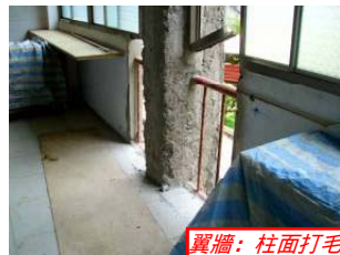
翼牆：柱面打毛
