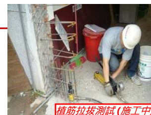
植筋拉拔測試 (施工前)
