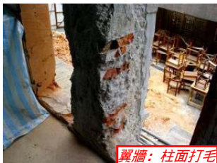
翼牆：柱面打毛
