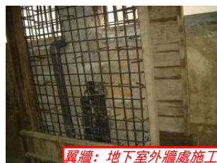
翼牆：地下室外牆處施工
