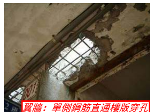
翼牆：單側鋼筋直通樓版穿孔
