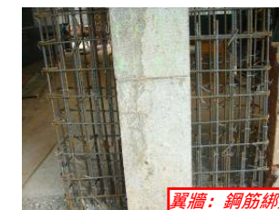
翼牆：鋼筋綁紮
