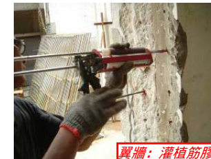
翼牆：植筋清孔
